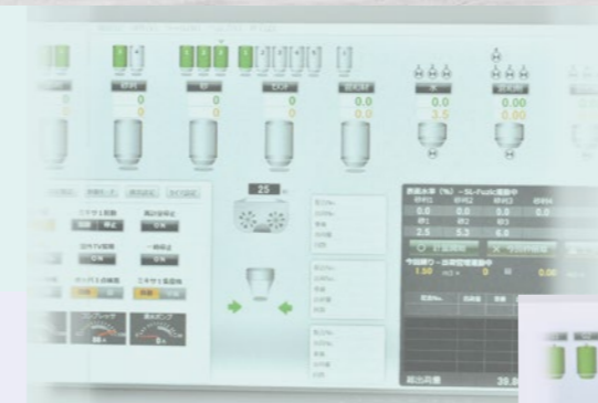
出荷管理装置
